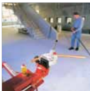
Gięcie na budowie
